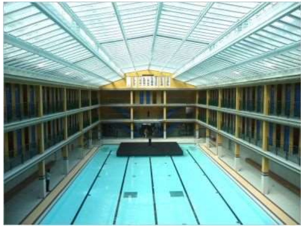
Après les travaux
