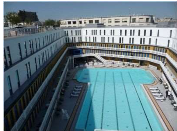
Après les travaux
