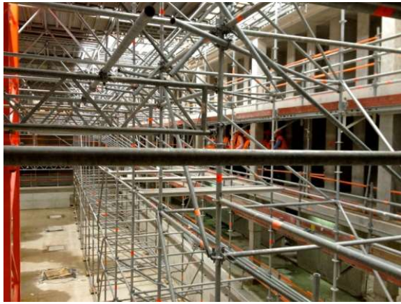
Le bassin d'hiver pendant le chantier
