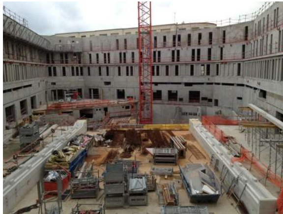
Le bassin d'été pendant le chantier
